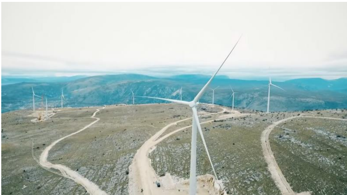
Slika 4. Vjetroelektrana Podveležje kod Mostara
