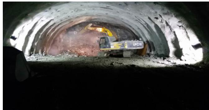
Slika 1: Iskop na čelu pomoću udarnog čekića<sup>1</sup>
