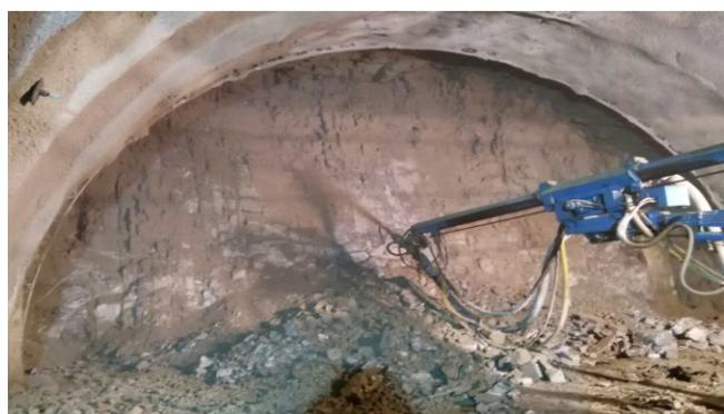
Slika 3 : Postupak nanošenja mlaznog betona<sup>3</sup>
