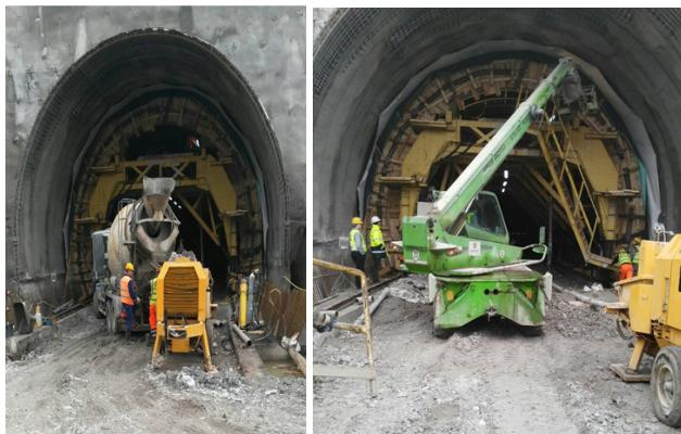
Slika 19. i 20. Postavljanje oplate i betoniranje tunela Pečuj<sup>9</sup>
