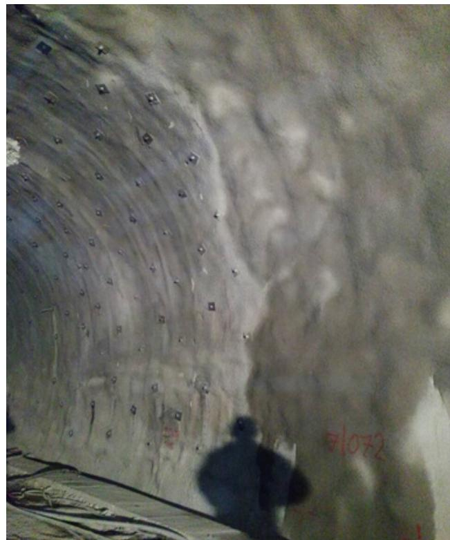
Slika 7. i 8. Frezanje sidara i nanošenje mlaznog betona<sup>6</sup>
