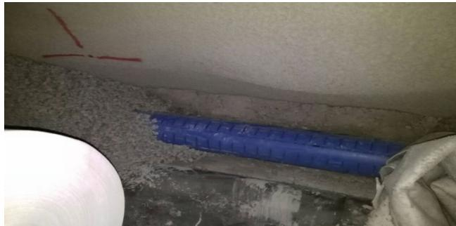
Slika 18: Zatrpanje drenažne cijevi suhim betonom
